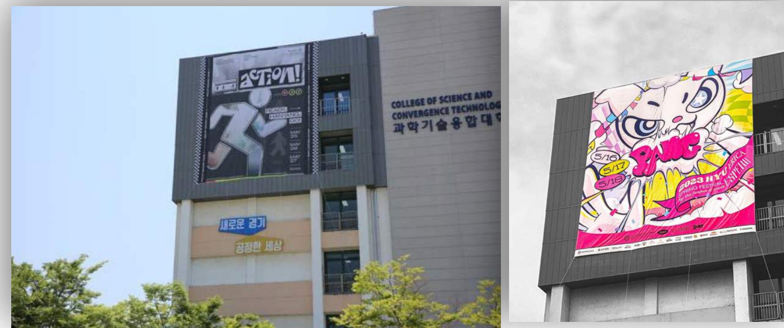
| 과학기술융합대학, 학생회관 등 건물 외벽 |
